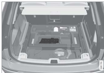
起动机蓄电池位于行李箱内。
